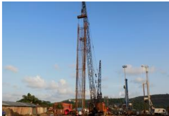
35 TON DIAPHRAGM.WALL CAGE LIFTING
